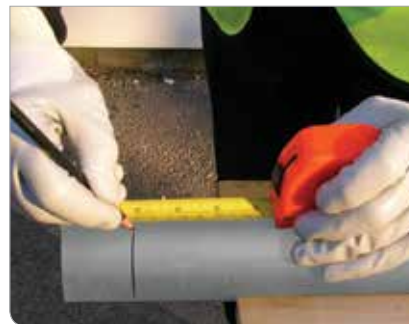
Рис. 3.22. Разметка трубы
