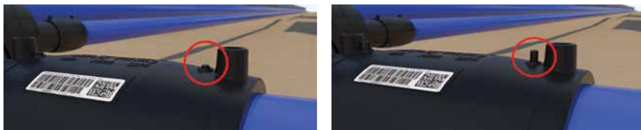
Рис. 3.50. Показания индикатора до (фото слева) и после (фото справа) успешной сварки
