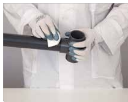
Рис. 3.10. Очистка соединения от избытков растворителя
