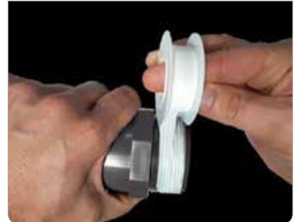
Рис. 3.63. Продолжение намотки ленты
