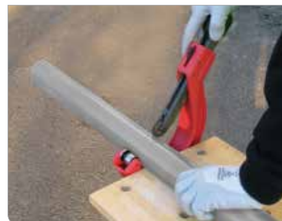
Рис. 3.20. Резка трубы
