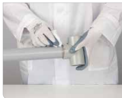
Рис. 3.18. Процесс сварки
