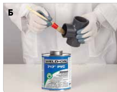
Рис. 3.8. Нанесение растворителя
