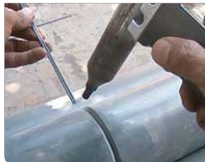
Рис. 3.54. Начало сварочного процесса
