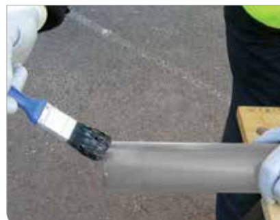
Рис. 3.24. Нанесение растворителя
