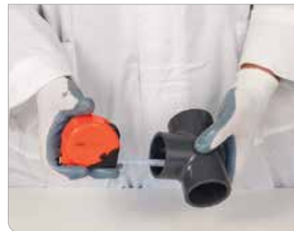
Рис. 3.5. Определение глубины растрюба
