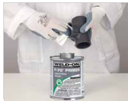
Рис. 3.7. Очистка трубы и фитинга
