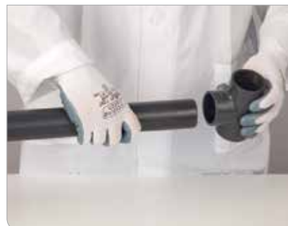
Рис. 3.9. Ввод трубы в фитинг
