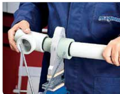
Рис. 3.42. Установка деталей на нагреватель
