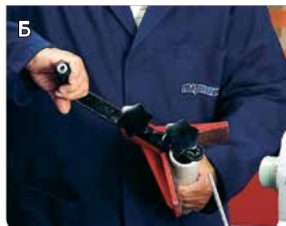
Рис. 3.38. Обрезка трубы и снятие фаски
