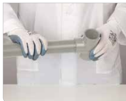
Рис. 3.19. Фиксация соединения
