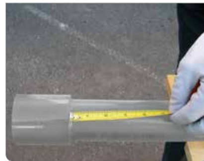
Рис. 3.26. Проверка сваренного соединения
